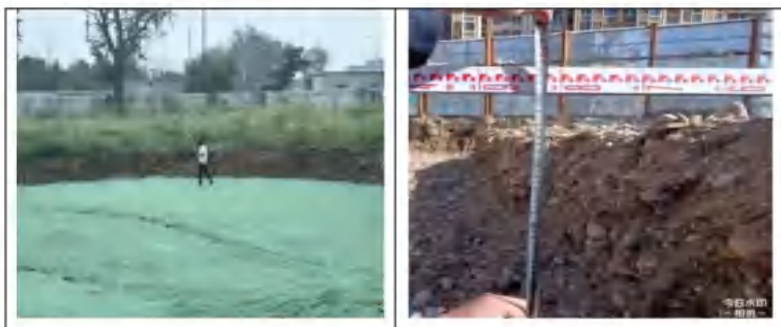
图 3.3.2-2 清挖完成后的复核测量
