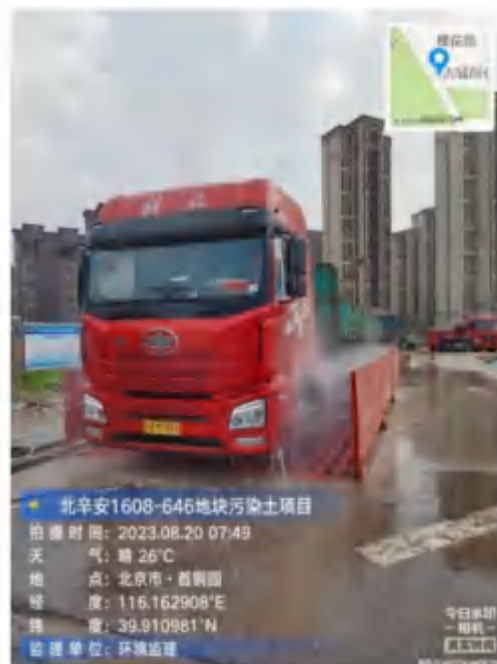
图 3.4.5-2 污染土运输车辆冲洗
