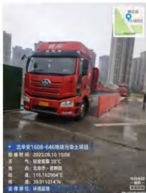
图 3.4.5-2 污染土运输车辆冲洗
