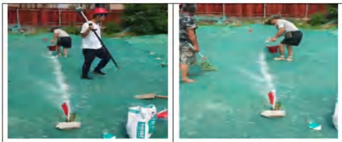
图 3.3.2-1 开工前的定位放线
