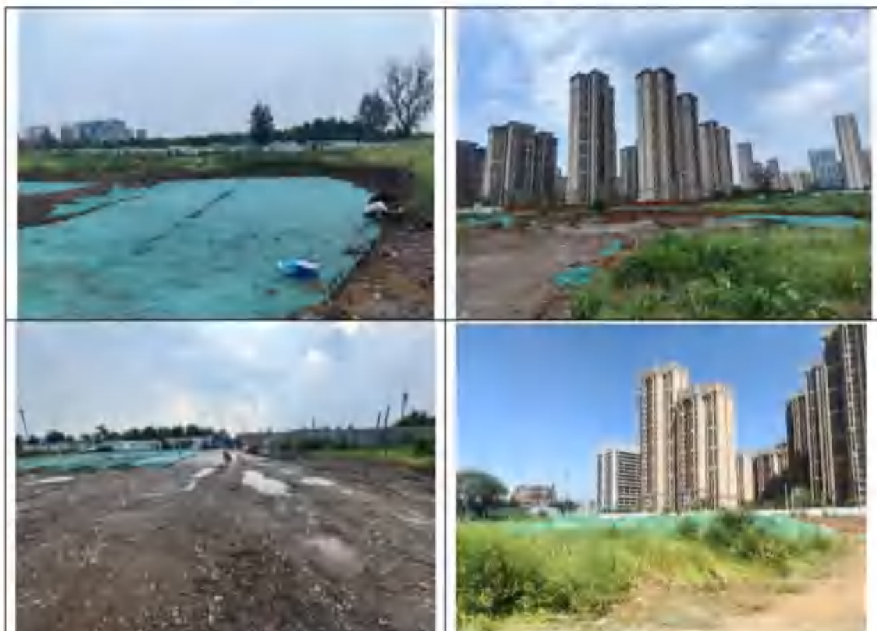
图 4.2-1 现场踏勘照片
