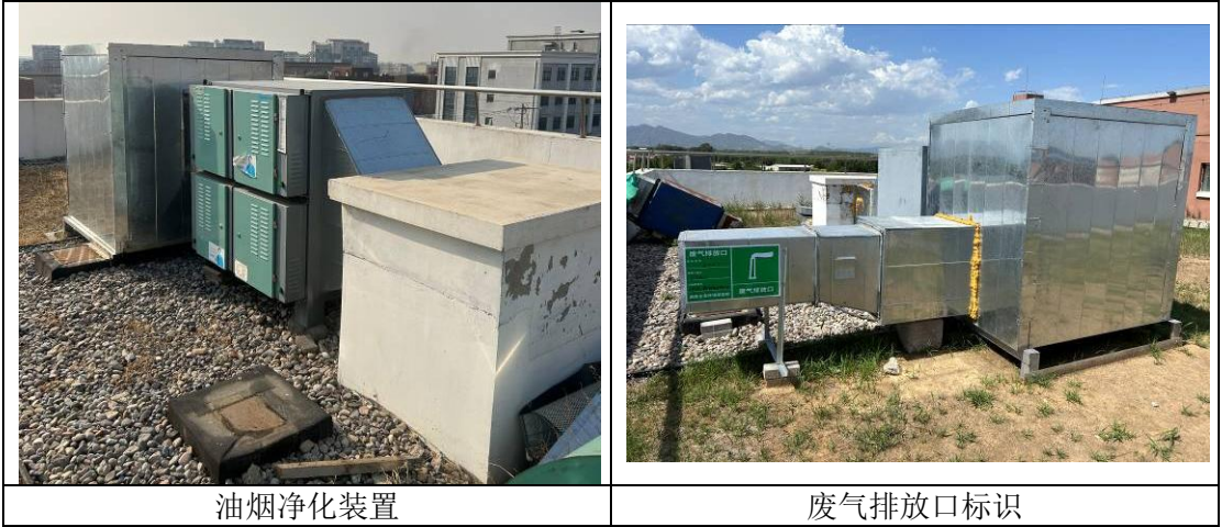
图 3-1 废气处理设施及排放口标识
