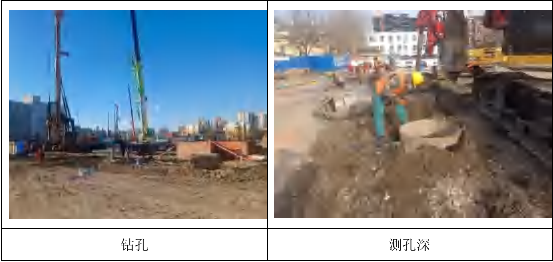
图 3.5-3 钻孔与测孔深
