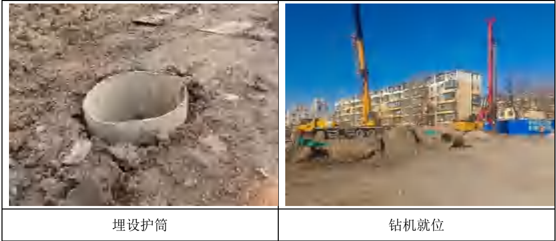
图 3.5-2 护坡桩施工
