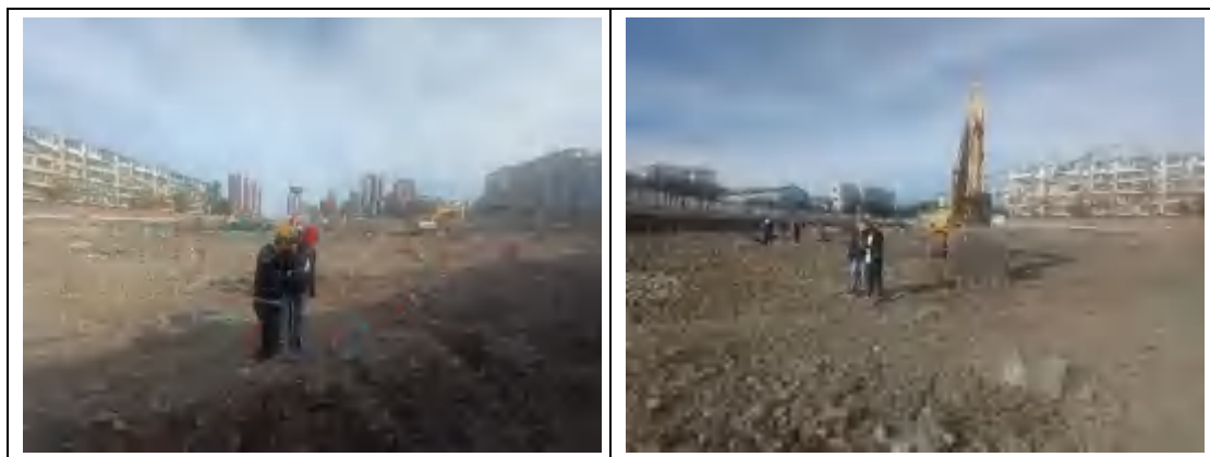
图 3.5-13 第三层污染土测量放线、监理验线
