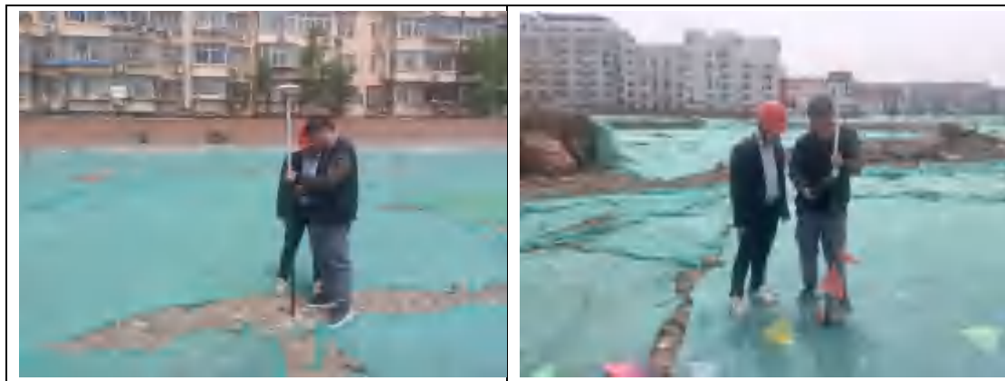
图 3.5-12 第二层污染土测量放线、监理验线
