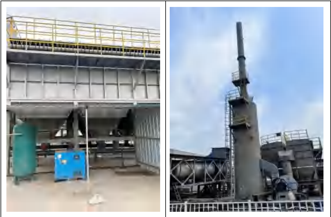
图 3.9-12 热脱附设施烟气净化系统
