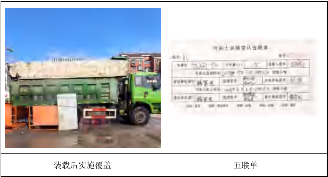
图 3.9-8 装载后覆盖及发放五联单
