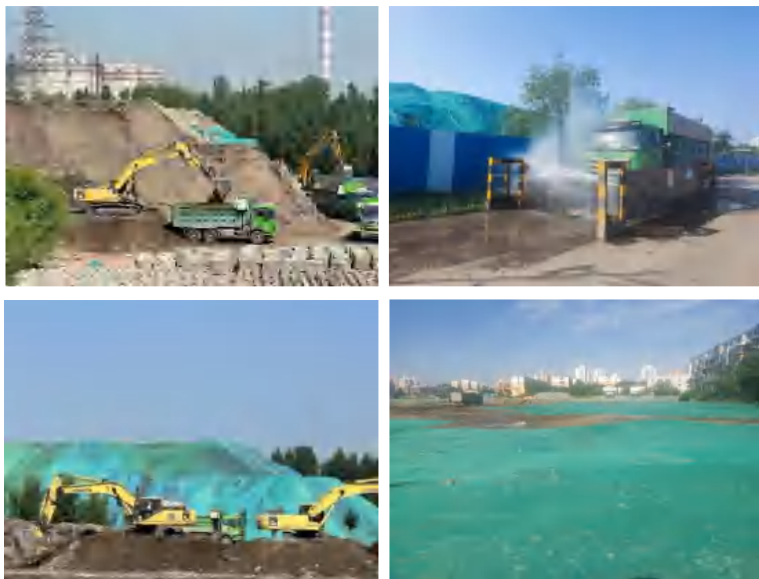
图 3.7-1 污染土回填过程影像
