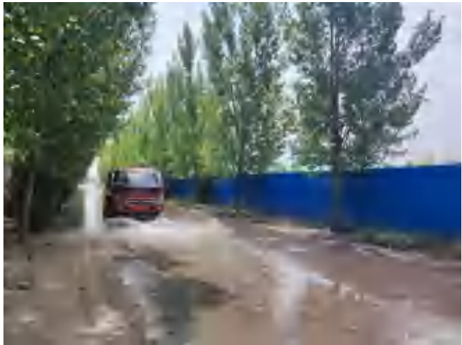
图 3.6-20 淋洗废水洒水抑尘
