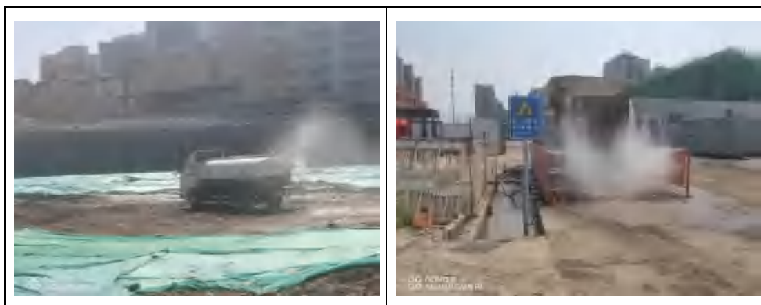
图 3.9-4 场内道路洒水降尘及运输车辆轮胎清洗
