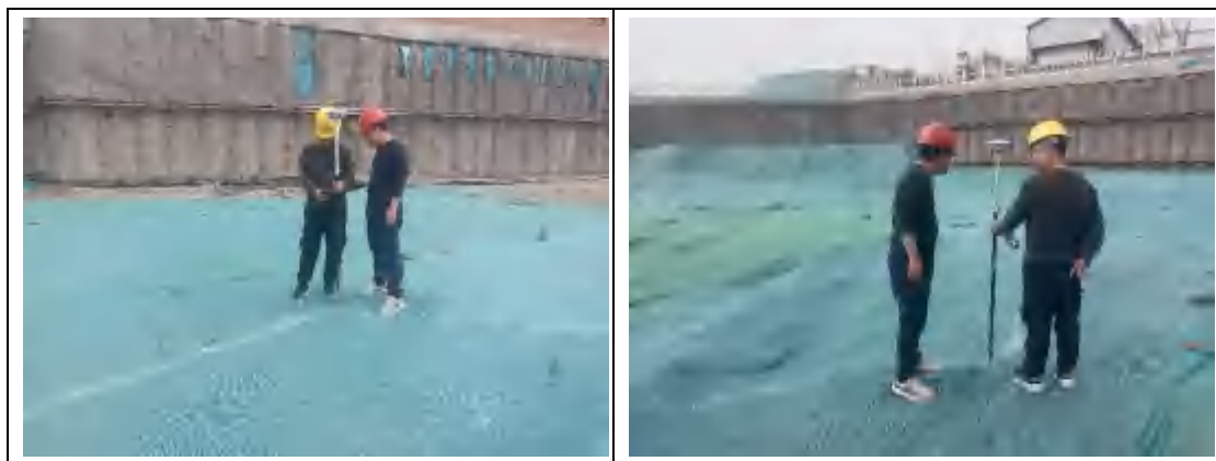
图 3.5-15 第五层污染土测量放线、监理验线
