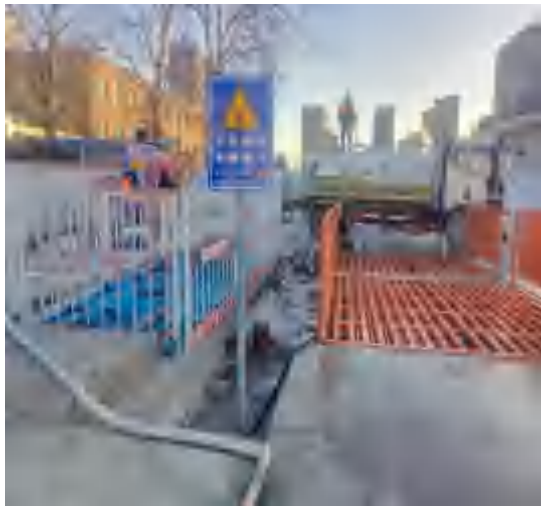
图 3.9-16 洗车池废水收集清理
