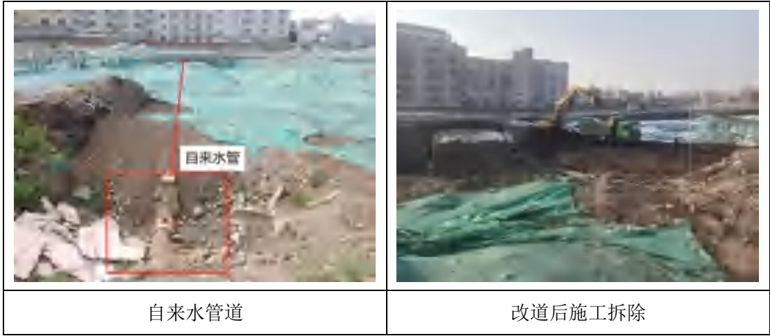
图 3.5-16 自来水管道拆除影像
