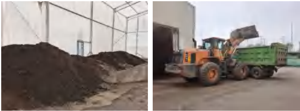
图 3.6-12 复合污染土异位热脱附后堆存图
