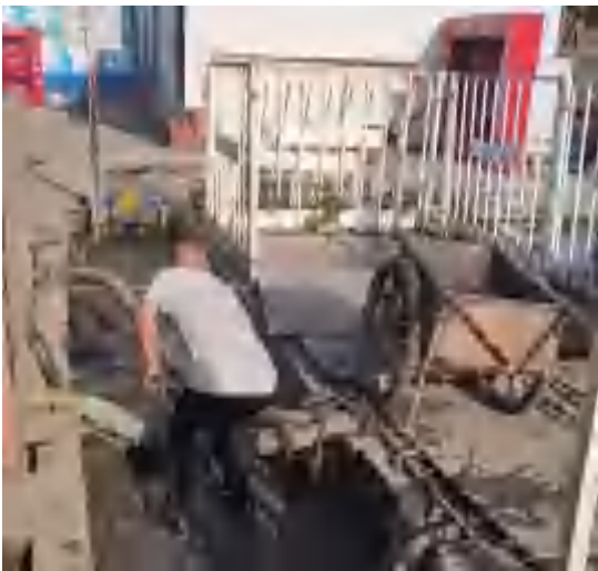
图 3.9-18 洗车池淤泥收集清理
