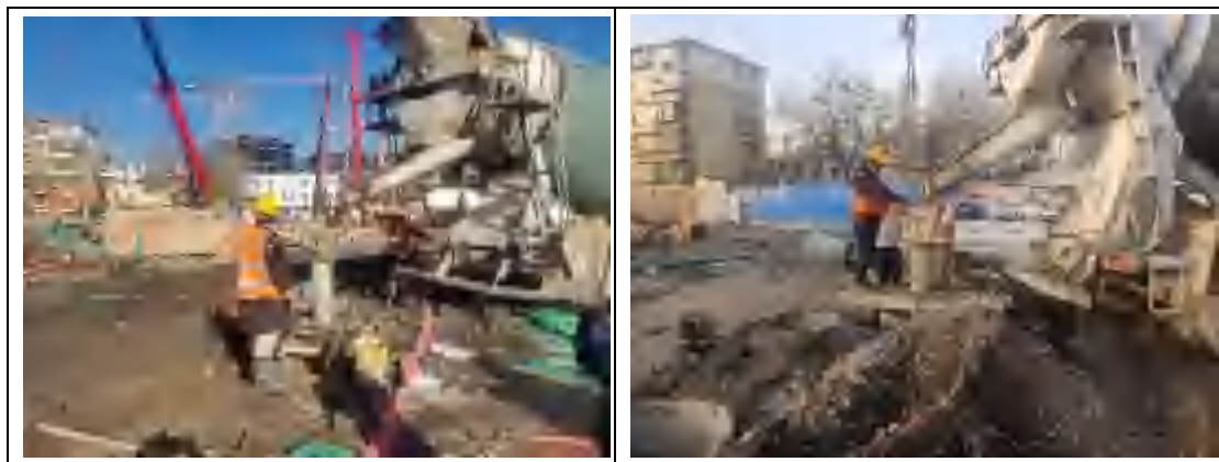
图 3.5-6 混凝土灌注
