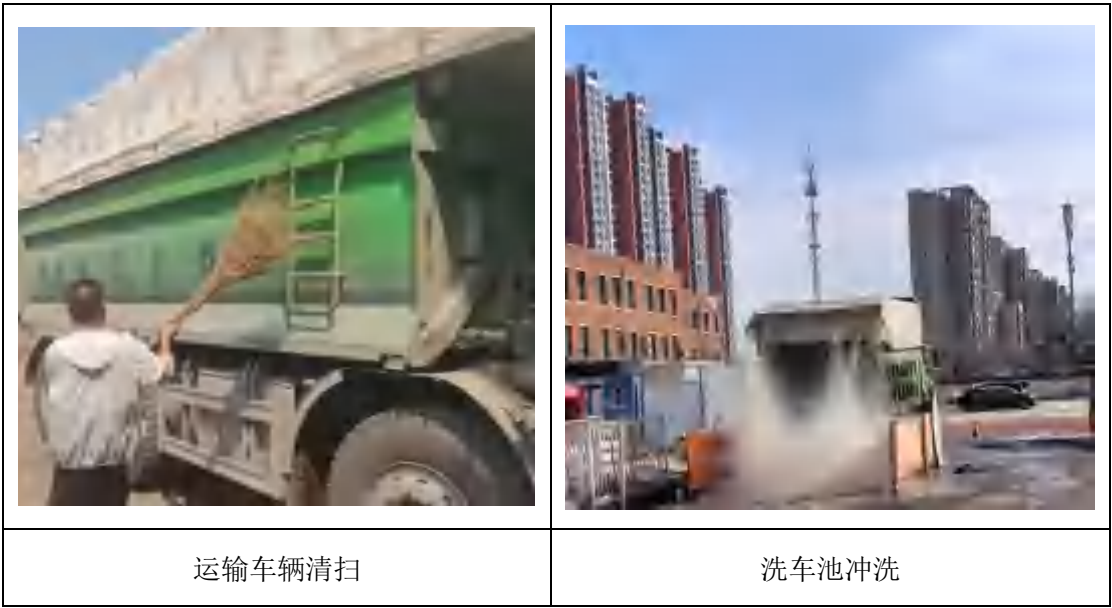
图 3.9-9 运输车辆清扫冲洗
