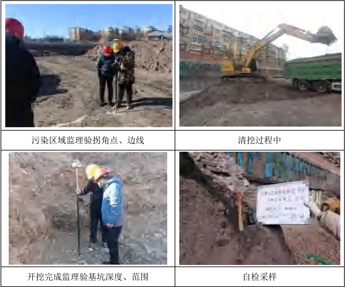
图 3.5-21 第四层（5-8m）污染土清挖现场施工过程影像
