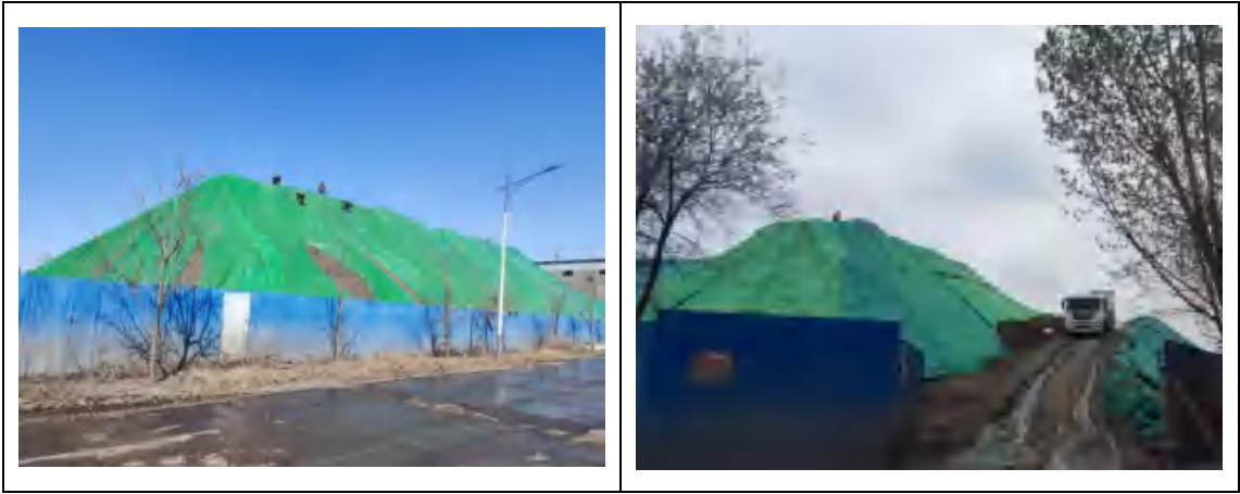
图 3.9-14 清洁土及热脱附成品土堆场苫盖及洒水抑尘
