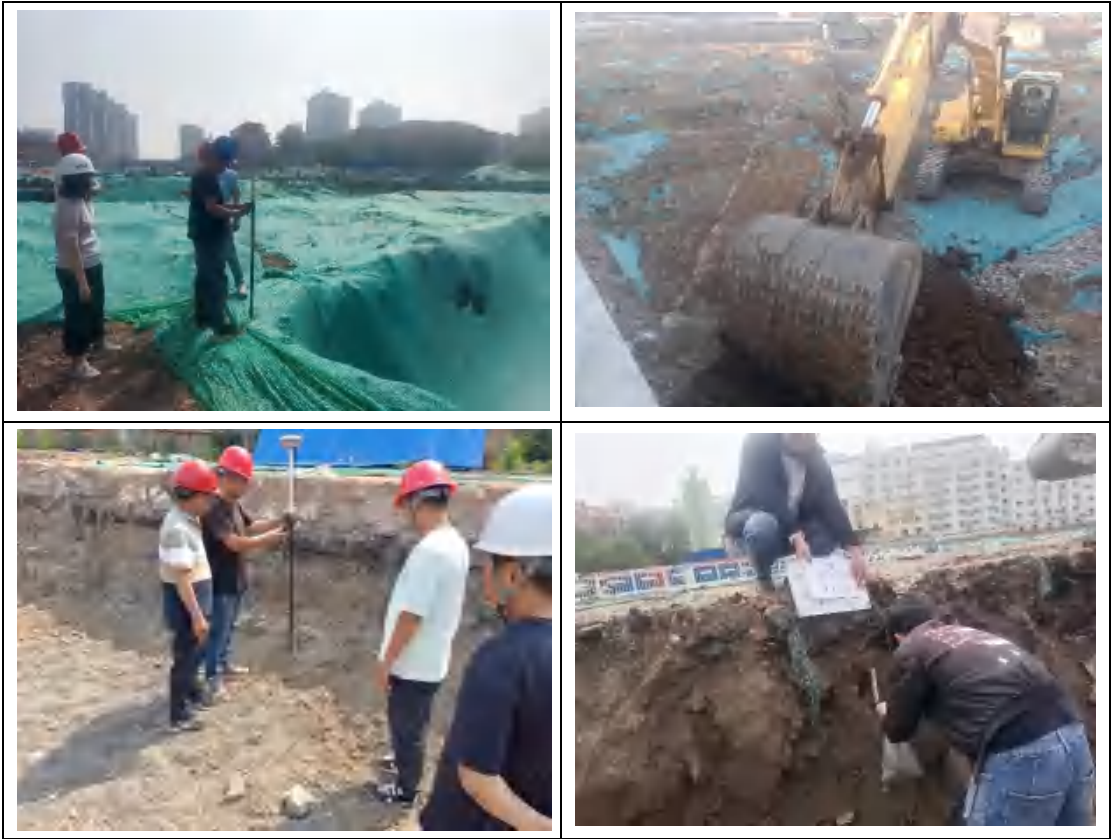
图 3.5-22 第一层（0-1m）扩挖过程影像
