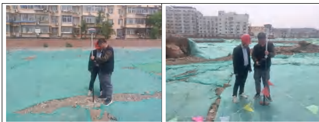
图 3.5-9 第二层污染土测量放线、监理验线
