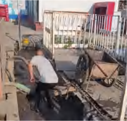
图 3.9-18 洗车池淤泥收集清理
