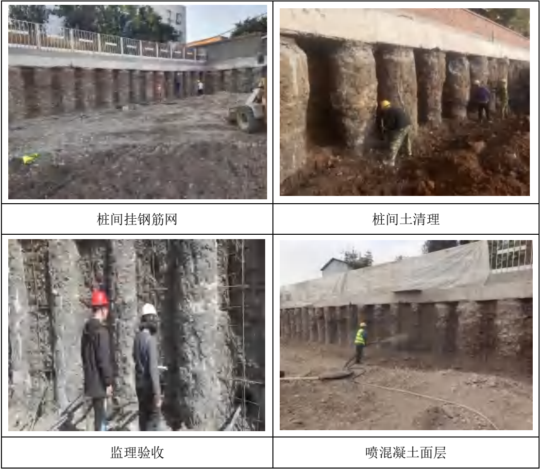
图 3.5-6 桩间护壁施工过程
