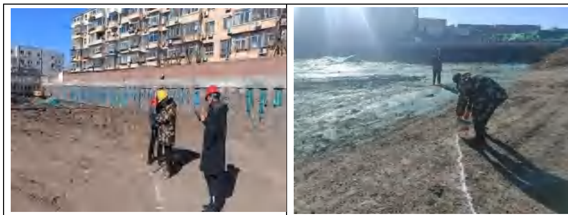
图 3.5-11 第四层污染土测量放线、监理验线
