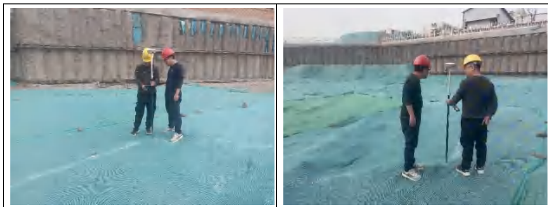
图 3.5-12 第五层污染土测量放线、监理验线
