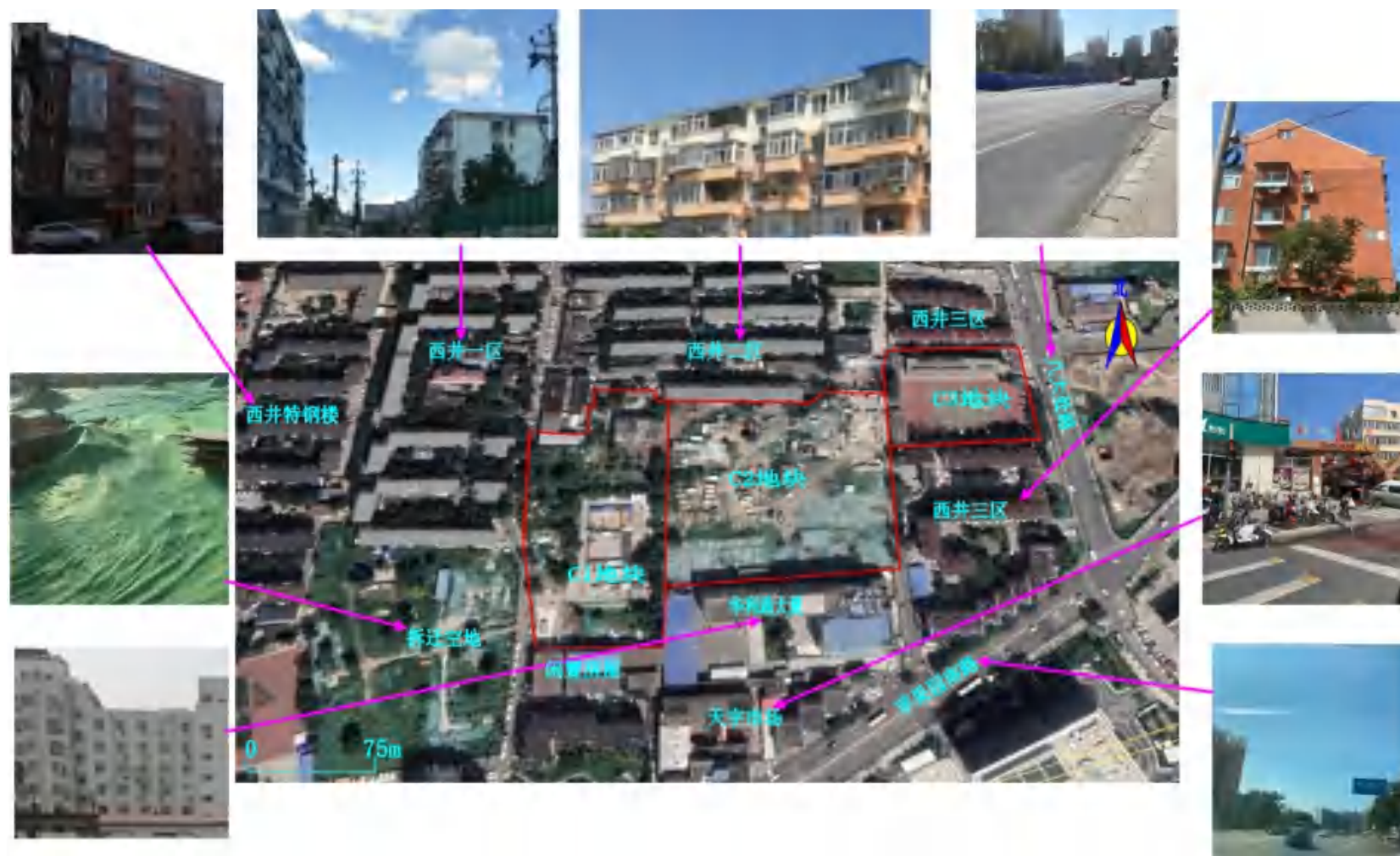
图 2.1-11 地块周边区域现状
