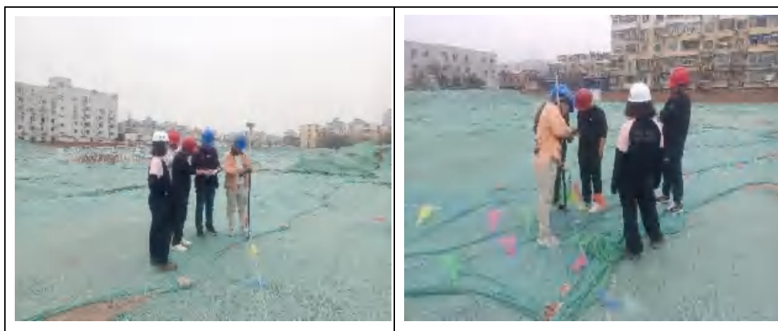
图 3.5-8 第一层污染土测量放线、监理验线
