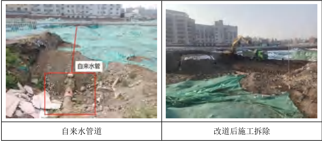
图 3.5-13 自来水管道拆除影像
