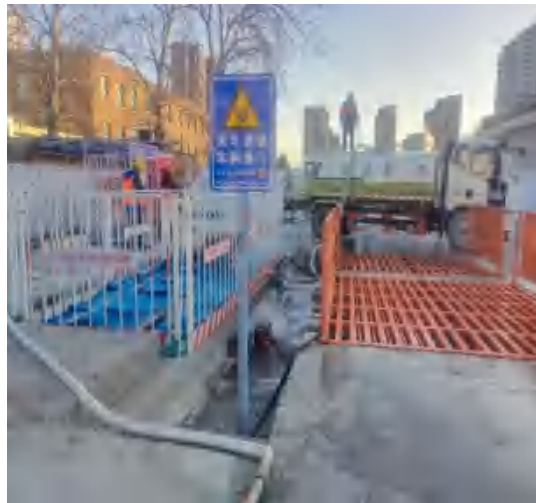
图 3.9-16 洗车池废水收集清理
