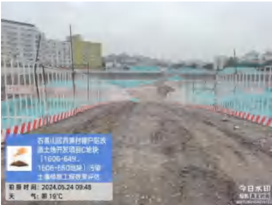
施工便道周边环境
