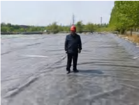
图 3.9-23 成品土待检区防渗措施
