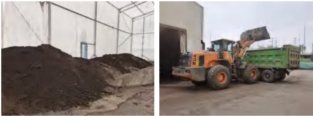
图 3.6-12 复合污染土异位热脱附后堆存图
