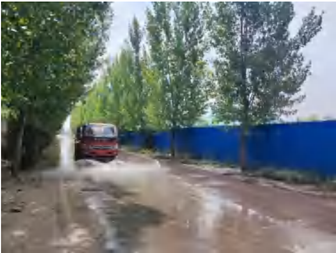
图 3.6-20 淋洗废水洒水抑尘
