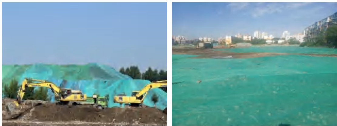
图 3.7-1 污染土回填过程影像
