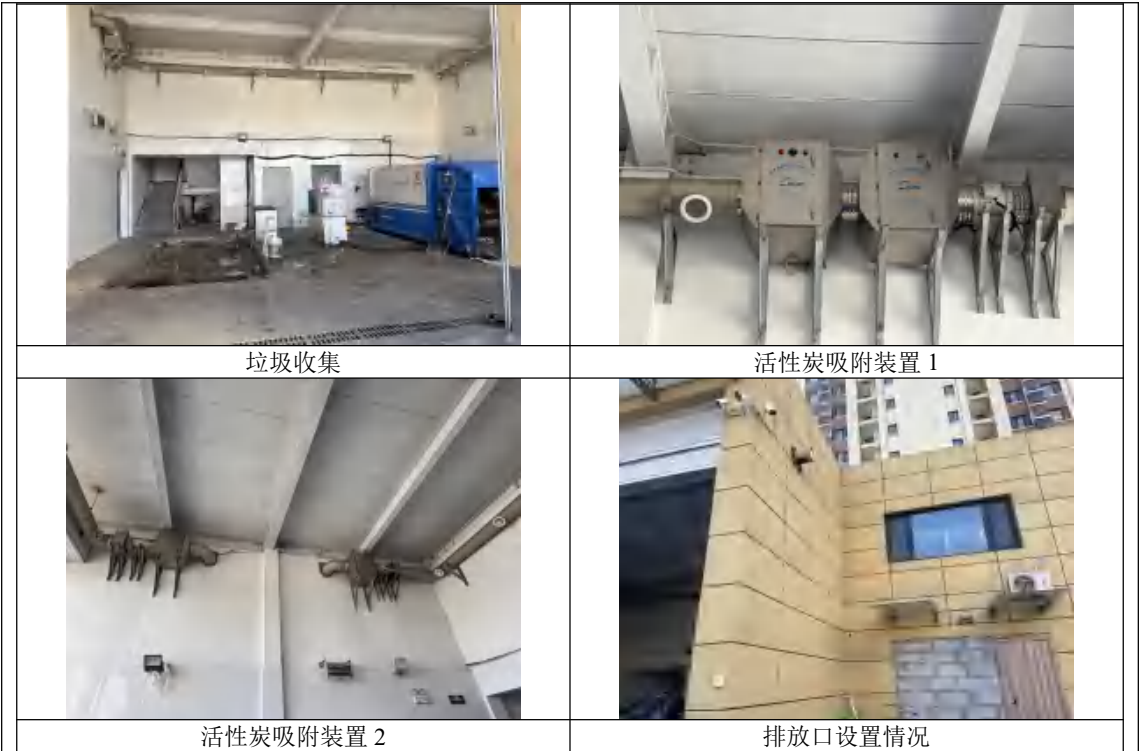
图 3-3 密闭式垃圾分类收集站垃圾收集、送、排风系统及活性炭吸附装置
