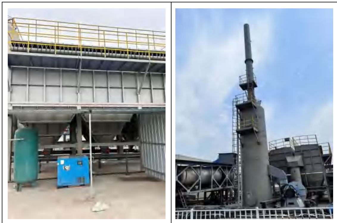
图 3.9-12 热脱附设施烟气净化系统
