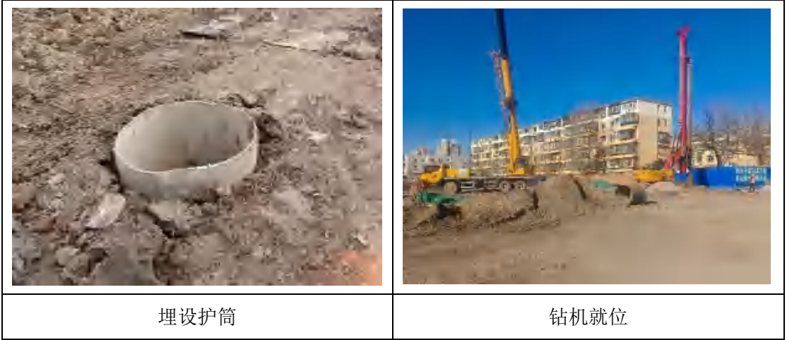
图 3.5-3 护坡桩施工
