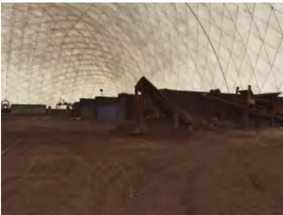
图 3.9-24 密闭大棚内部防渗措施
