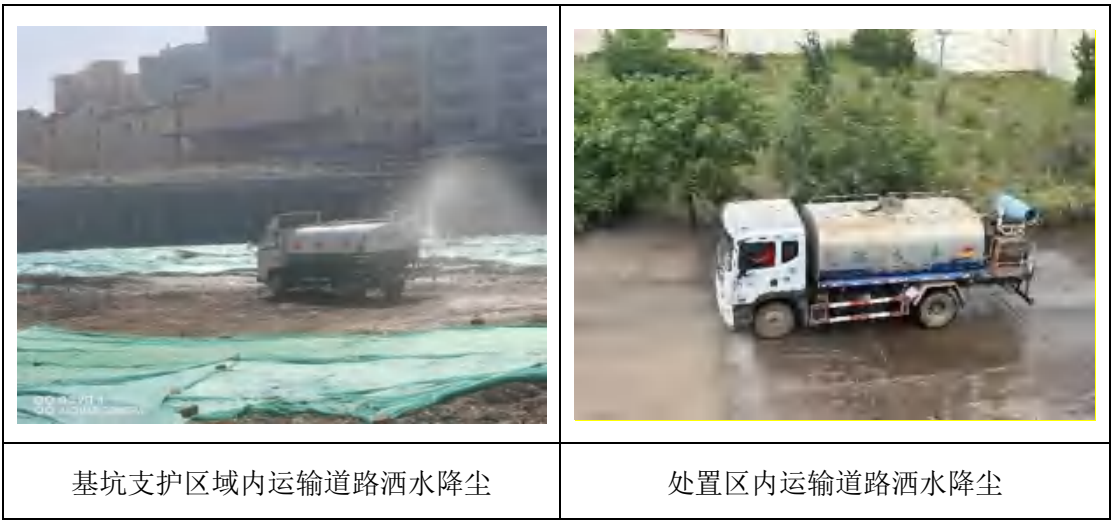
图 3.9-8 施工便道洒水降尘
