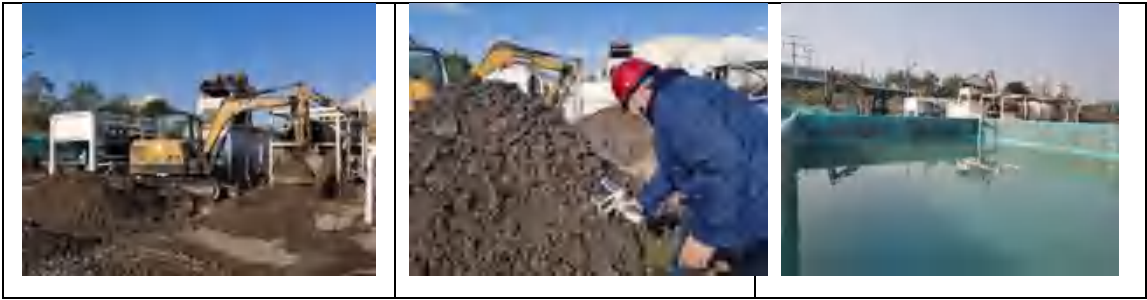
图 3.6-15 化学淋洗设备及运行实景
