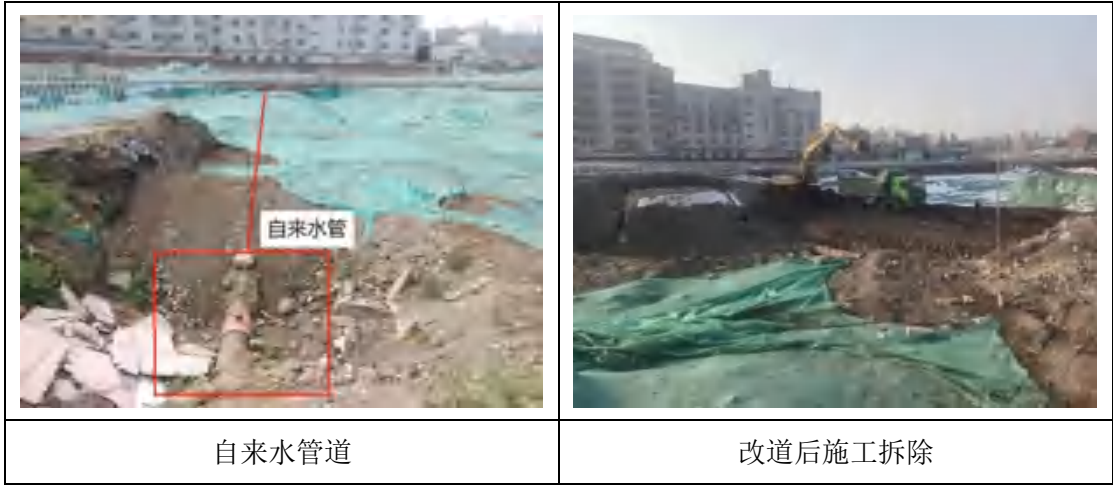
图 3.5-13 自来水管道拆除影像
