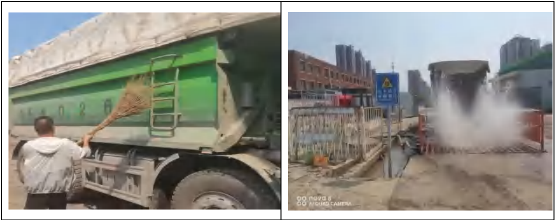
图 3.9-7 车辆苫盖、清扫及冲洗
