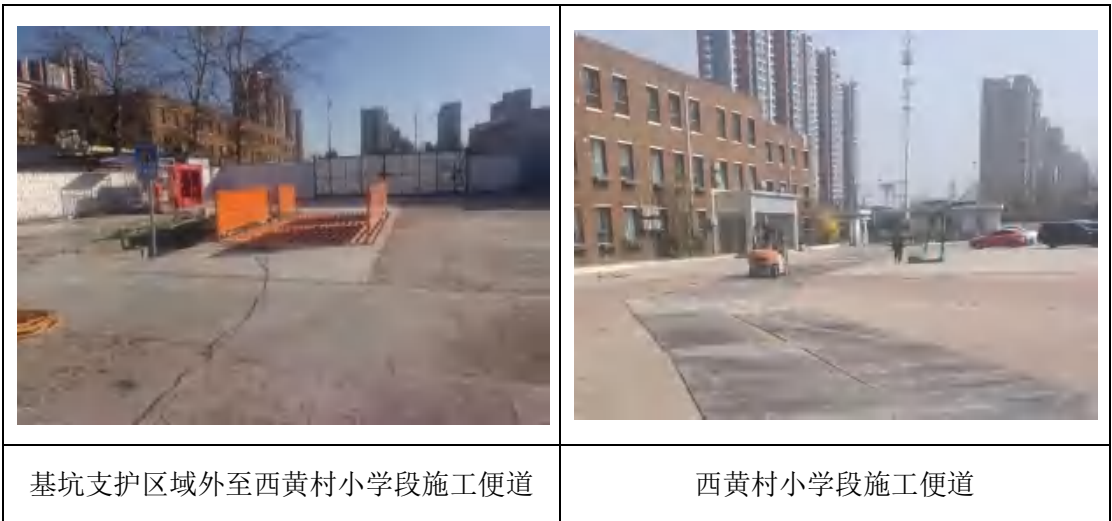
图 3.9-6 基坑支护区域外施工便道
