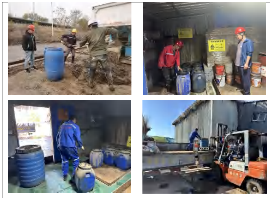
图 3.6-21 污泥泥饼收集、装车及外运
