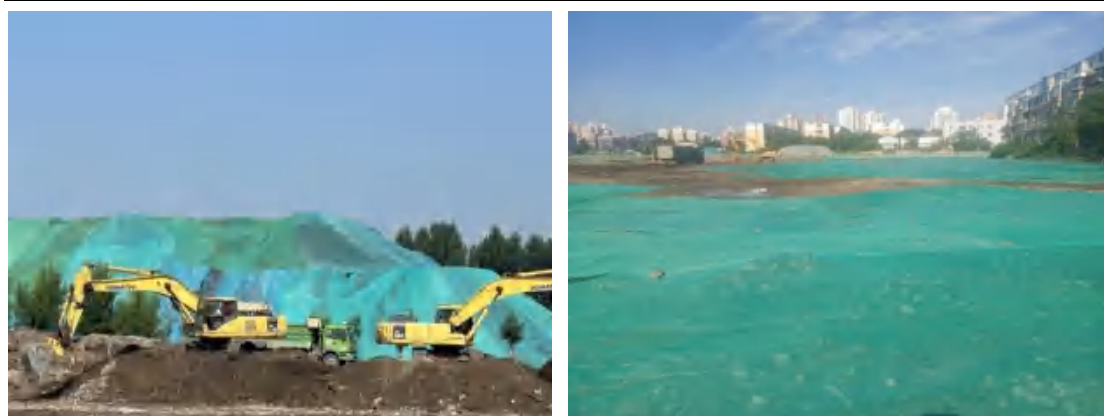
图 3.7-1 污染土回填过程影像
