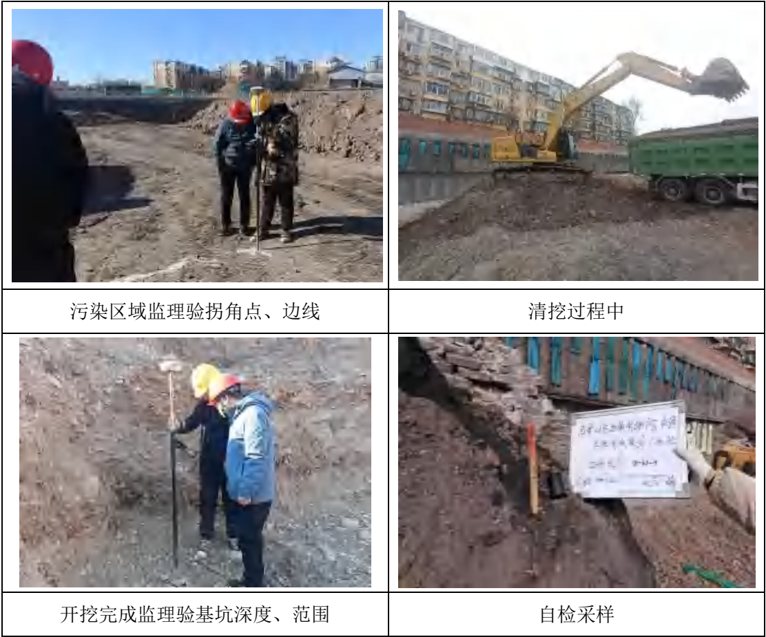
图 3.5-18 第四层（5-8m）污染土清挖现场施工过程影像
