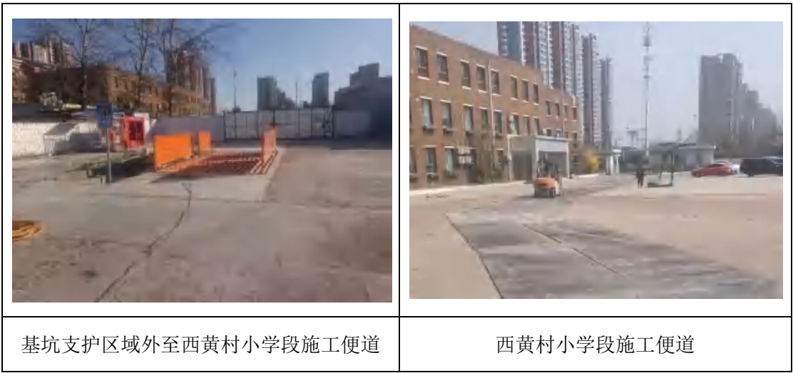
图 3.9-22 基坑支护区域外施工便道防渗措施
