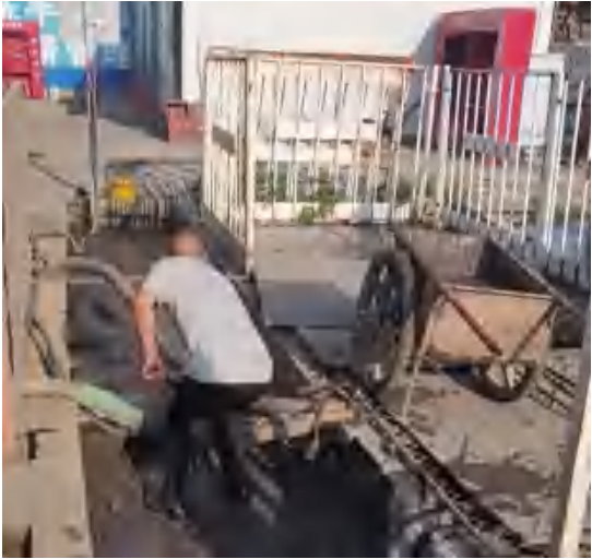
图 3.9-19 洗车池淤泥收集清理
