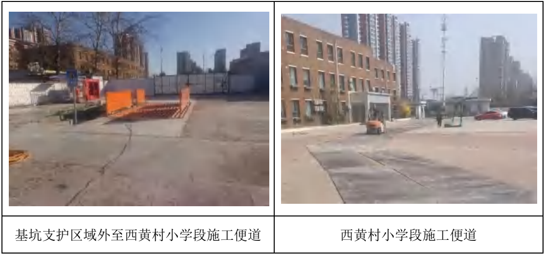
图 3.5-42 基坑支护区域外施工便道
