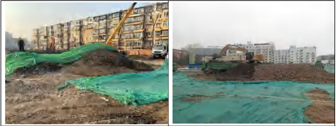
图 3.5-4 桩土堆放、外运
