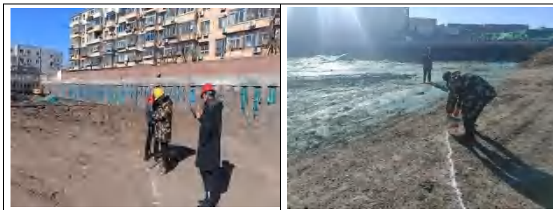
图 3.5-11 第四层污染土测量放线、监理验线
