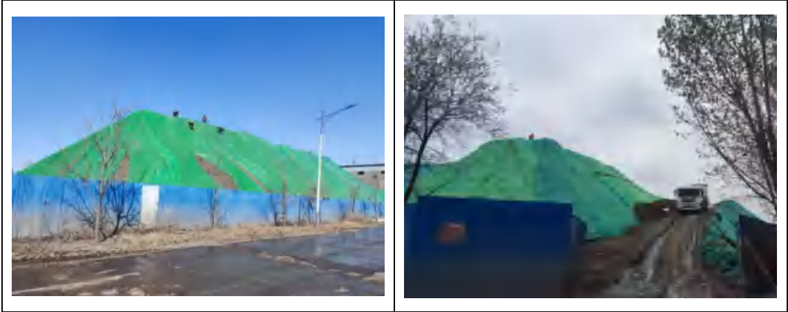
图 3.9-14 清洁土及热脱附成品土堆场苫盖及洒水抑尘
