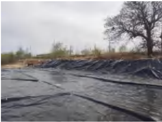
图 3.9-28 热脱附成品土待检区防渗措施
