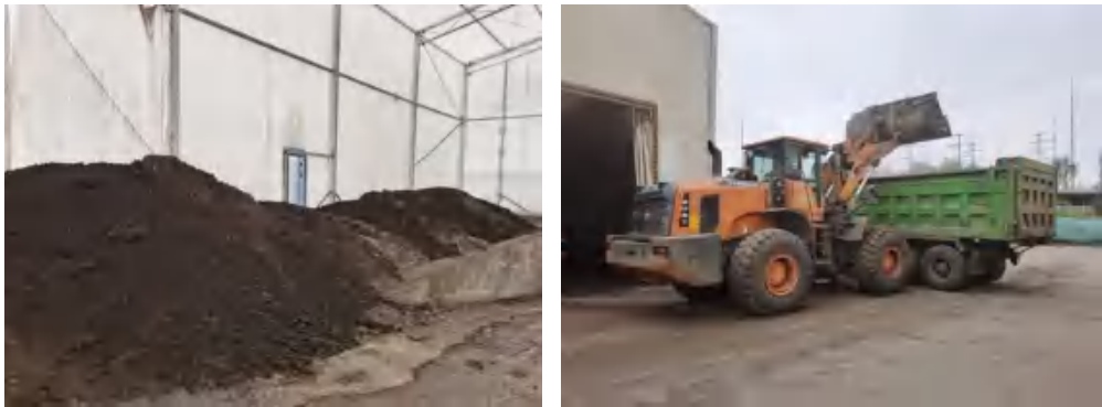
图 3.6-12 复合污染土异位热脱附后堆存图
