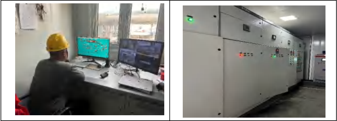
图 3.6-10 热脱附设备及运行实景
