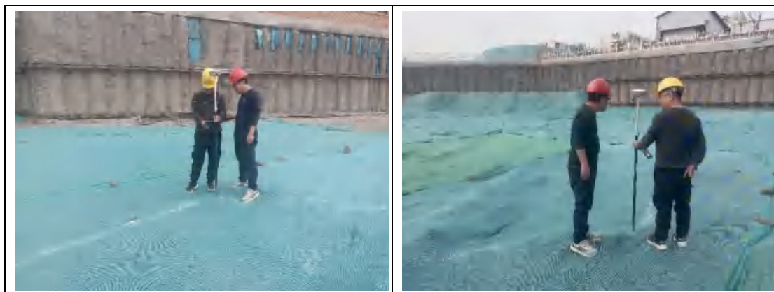
图 3.5-12 第五层污染土测量放线、监理验线
