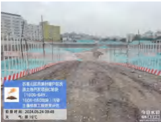
施工便道周边环境
