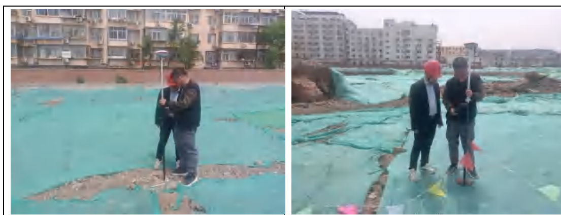
图 3.5-9 第二层污染土测量放线、监理验线
