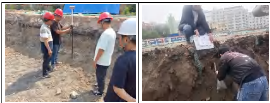
图 3.5-22 第一层（0-1m）扩挖过程影像
